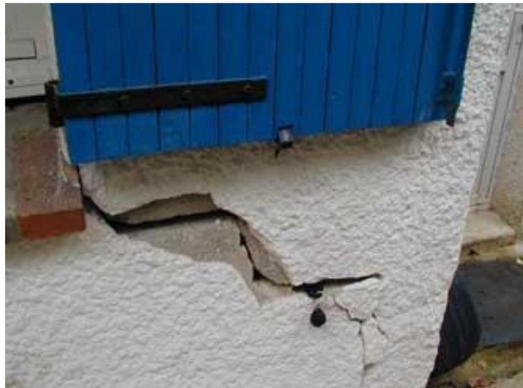
Ces tassements différentiels sont évidemment amplifiés en cas d'hétérogénéité du sol ou lorsque les fondations présentent des différences d'ancrage d'un point à un autre de la maison (cas des sous-sols partiels notamment, ou des pavillons construits sur terrain en pente).
