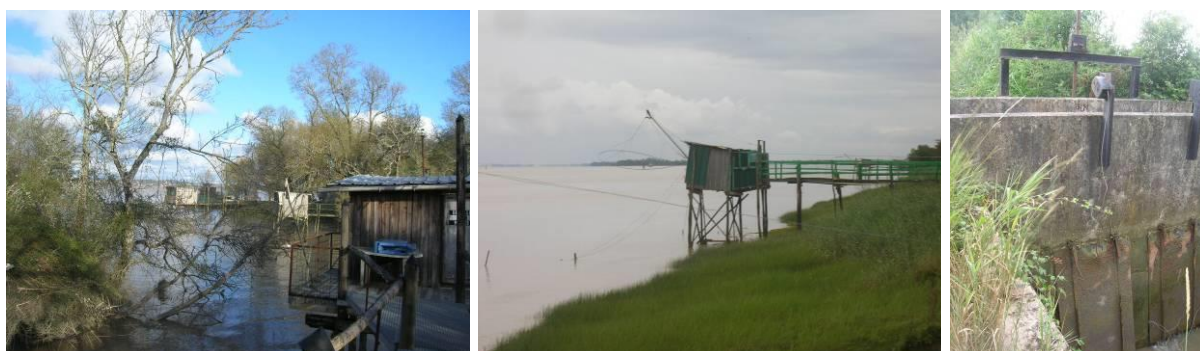
Préservation des digues et du système de drainage des palus
