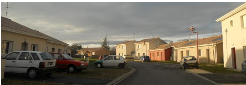
Effet de façade qui structure un espace partagé
